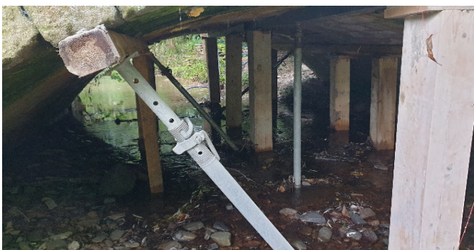
Abstützen des Gewölbes
