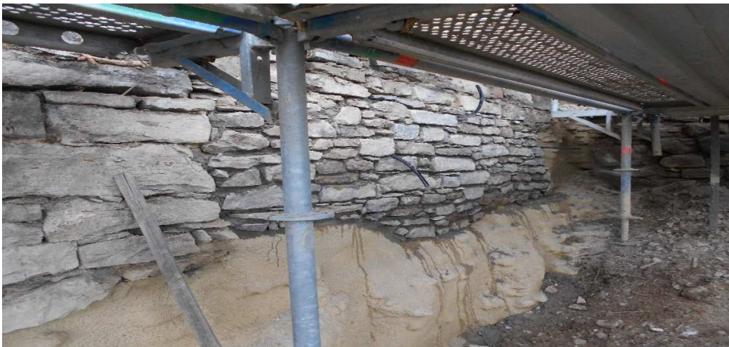
Verfüllen, Verpressen von Hohlstellen
