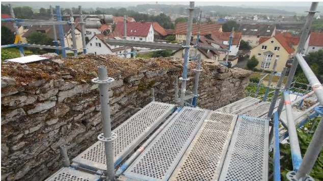
Verwitterte Schenkelmauer
