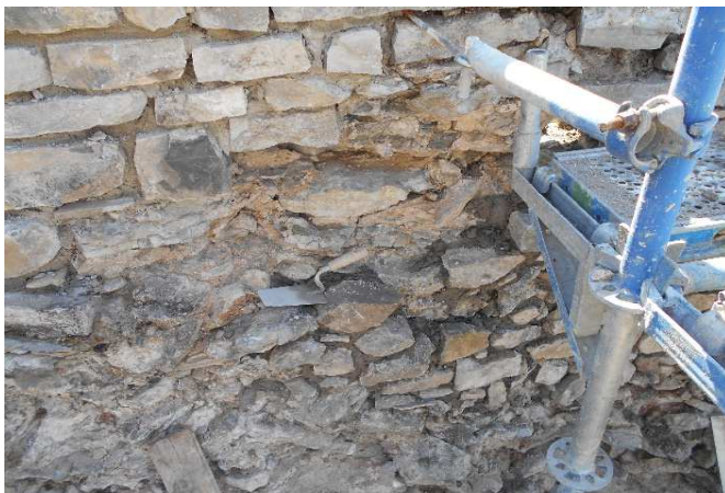
Beispiel Ausmauern der Fehlstellen
