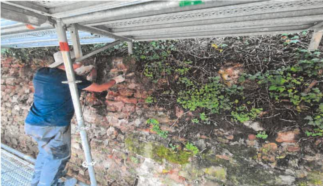
Freilegen der Mauer
