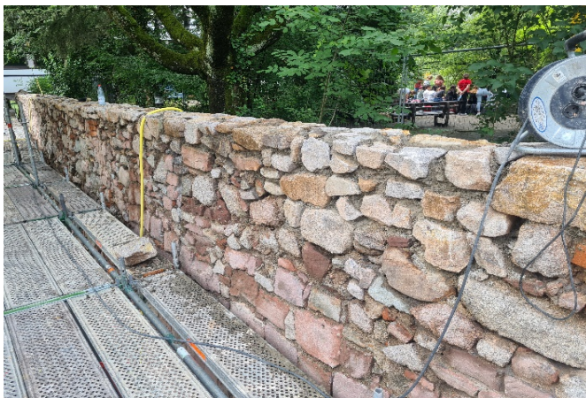
Vor der Verfugung
