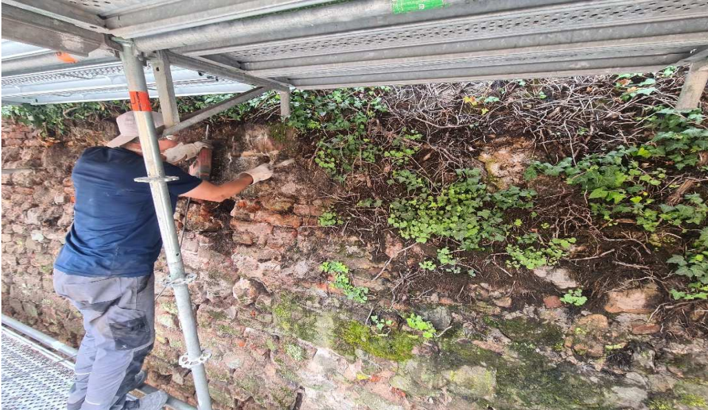
Freilegen der Mauer
