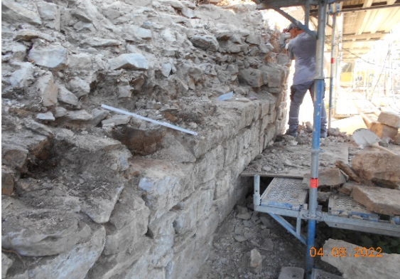
Stemm- und Mauerarbeiten
