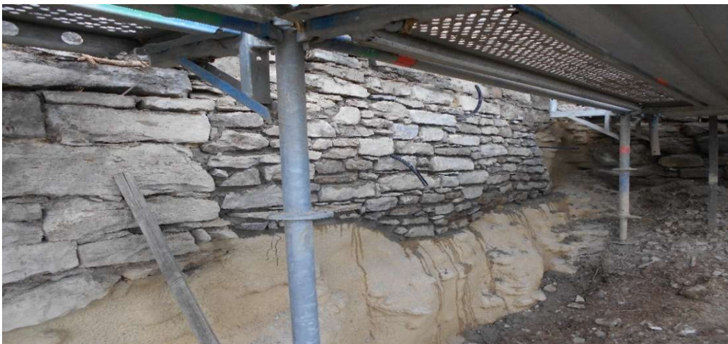
Verfüllen, Verpressen von Hohlstellen
