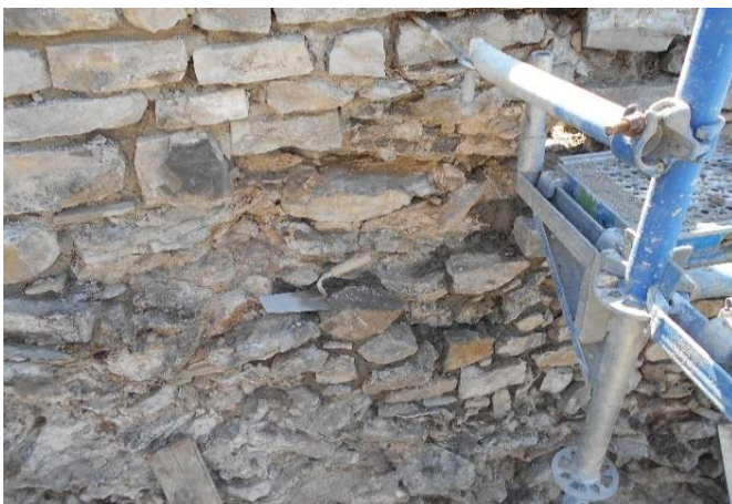
Beispiel Ausmauern der Fehlstellen
