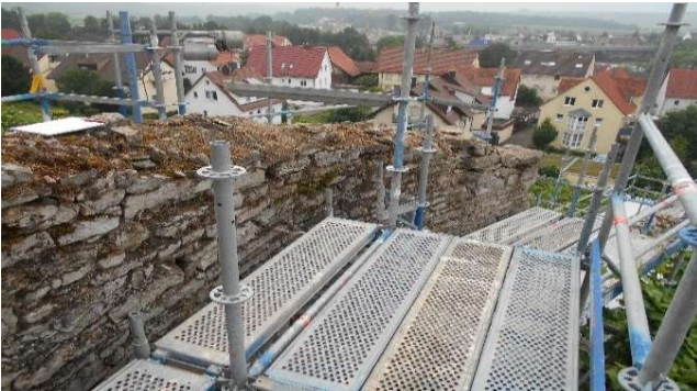
Verwitterte Schenkelmauer
