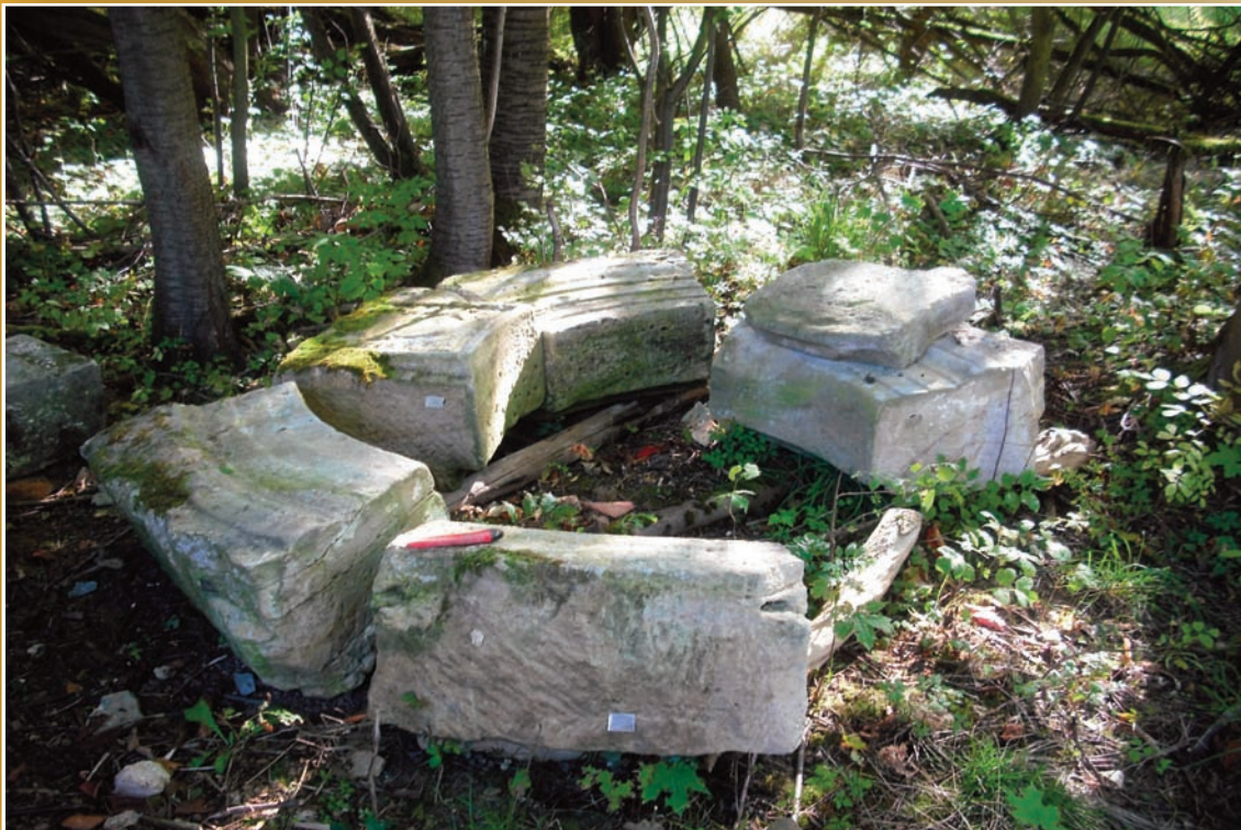
Teilabbau Portal T3.1, Hofgarten
