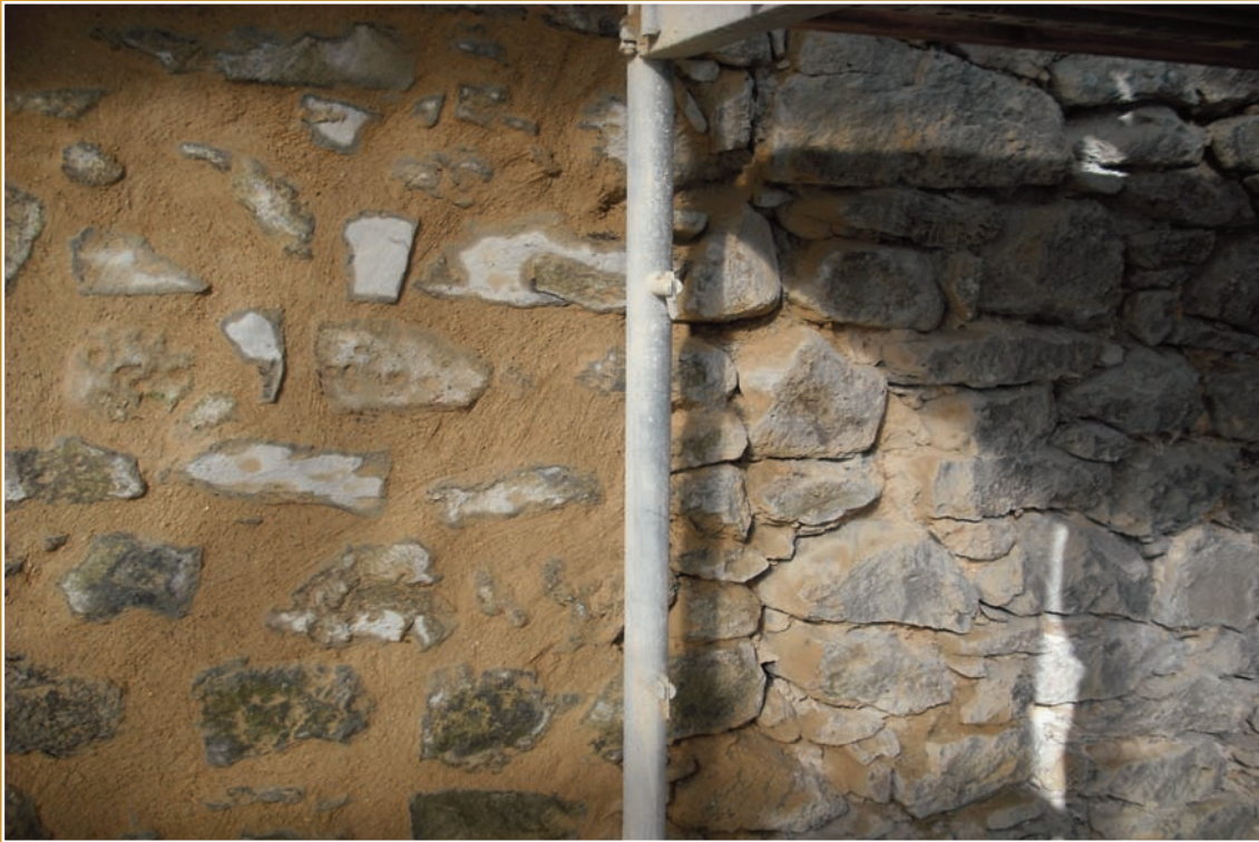
Maschinell verfugte Fläche vor der Reinigung
