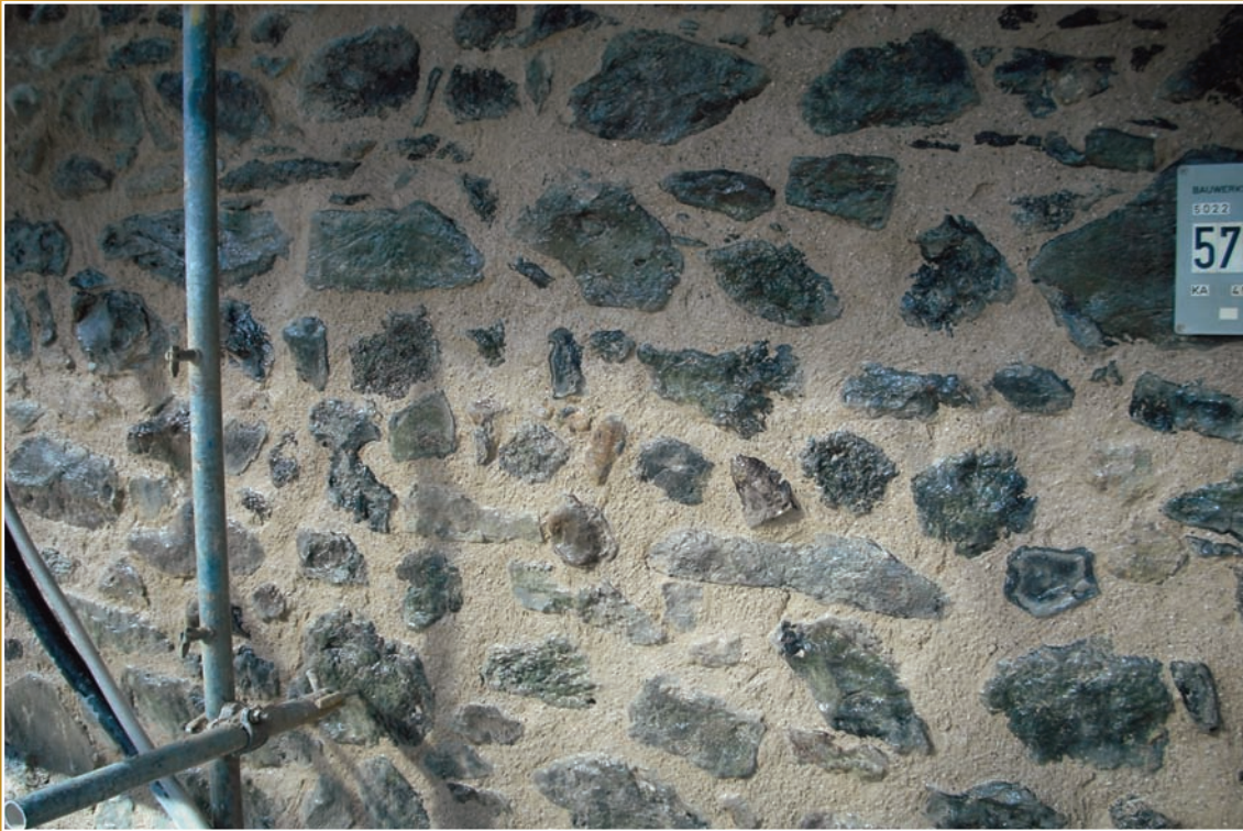
Maschinell verfugte Fläche nach der Reinigung
