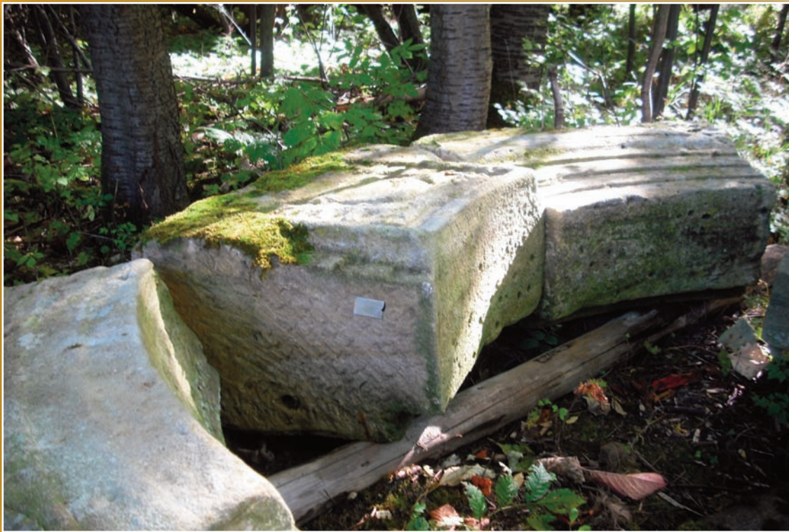
Teilabbau Portal T3.1, Hofgarten
