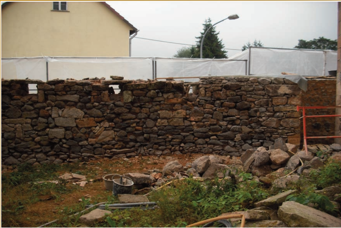
Mauer zwischen Pferdestall und Turm
