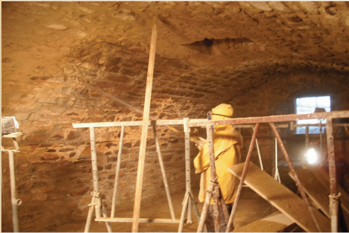
Maschinelle Steinsichtige Verfugung im Hochdruckspritzverfahren
