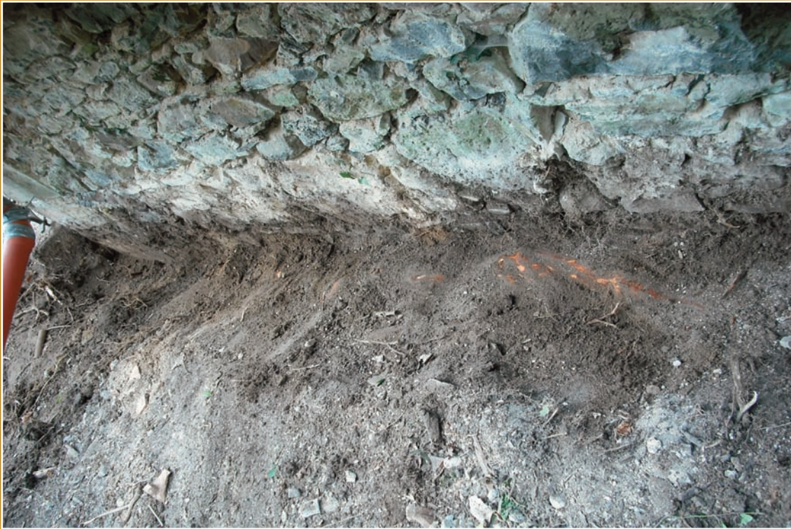
Erdarbeiten am Mauerfuß
