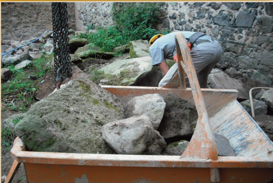
Sortieren der Natursteine für Mauerarbeiten
