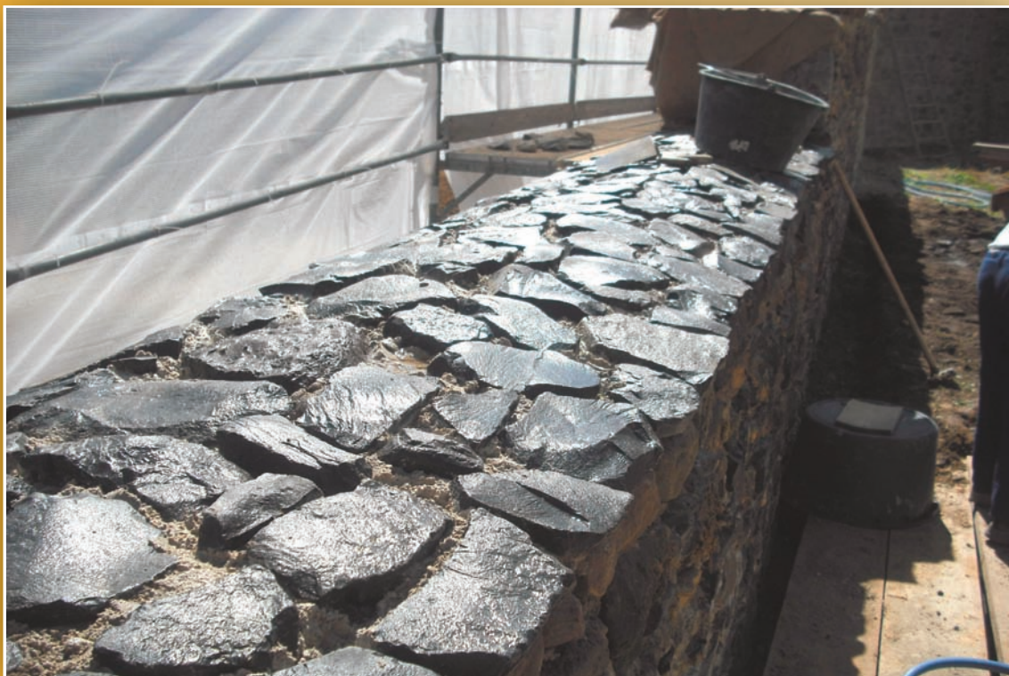
Feuchtbehandlung der Mauerkrone
