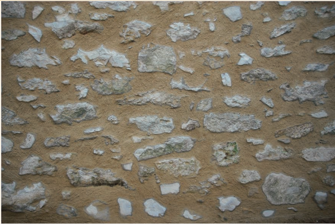
Neu verfugte Wandfläche mit eingebauten Zwickelsteinen
