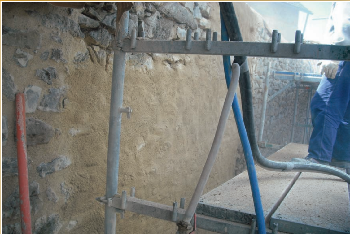
Neu verfugte Wandflächen
