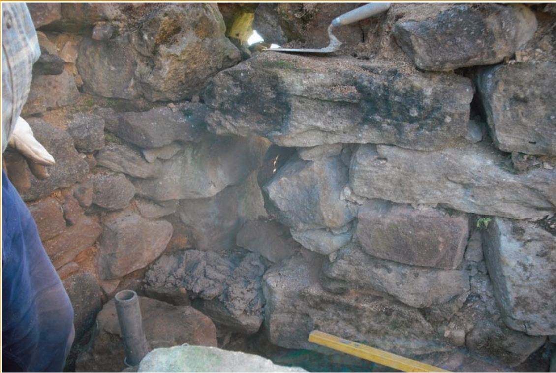
Mauerarbeiten am Eckturm
