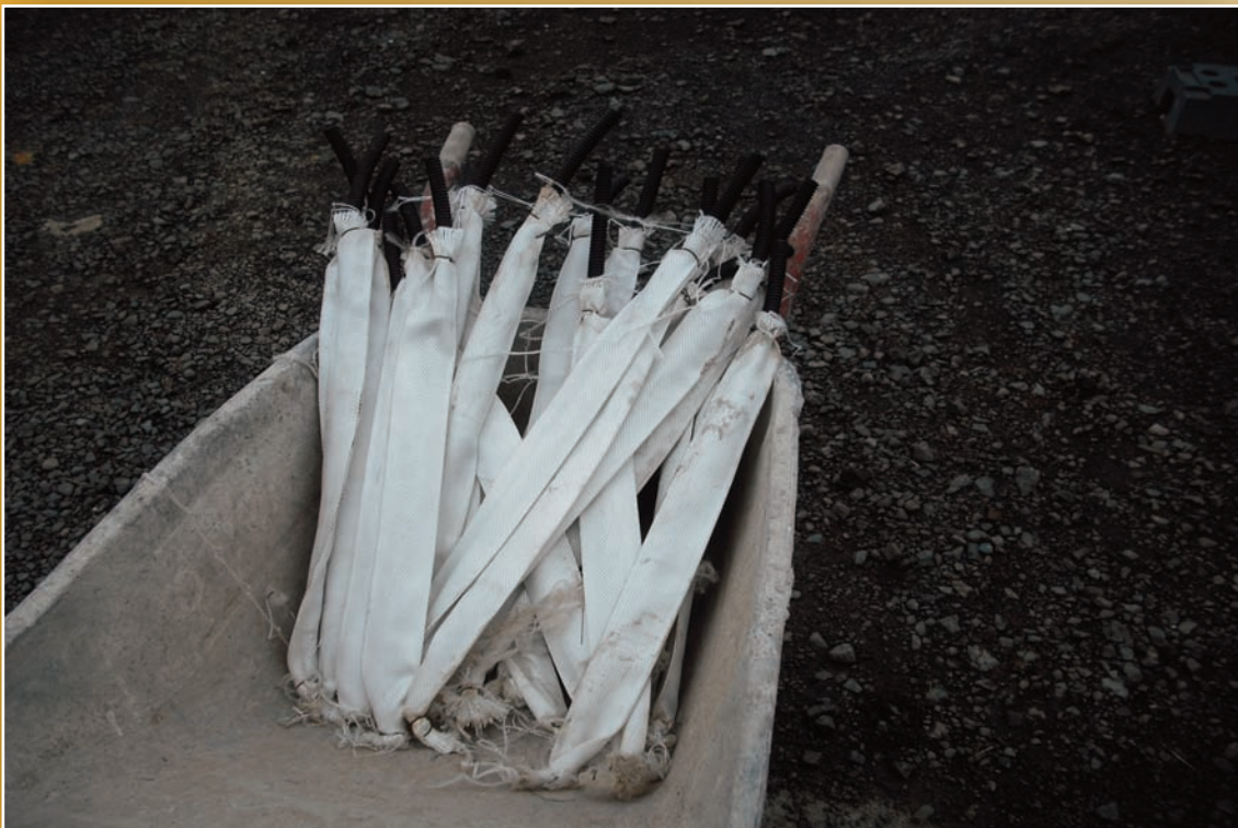
Nadelanker im Geotextil-Strumpf
