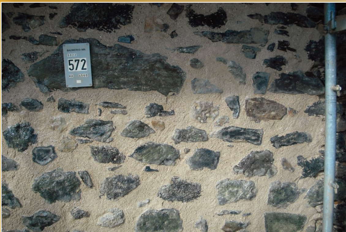
Maschinell verfugte Fläche nach der Reinigung
