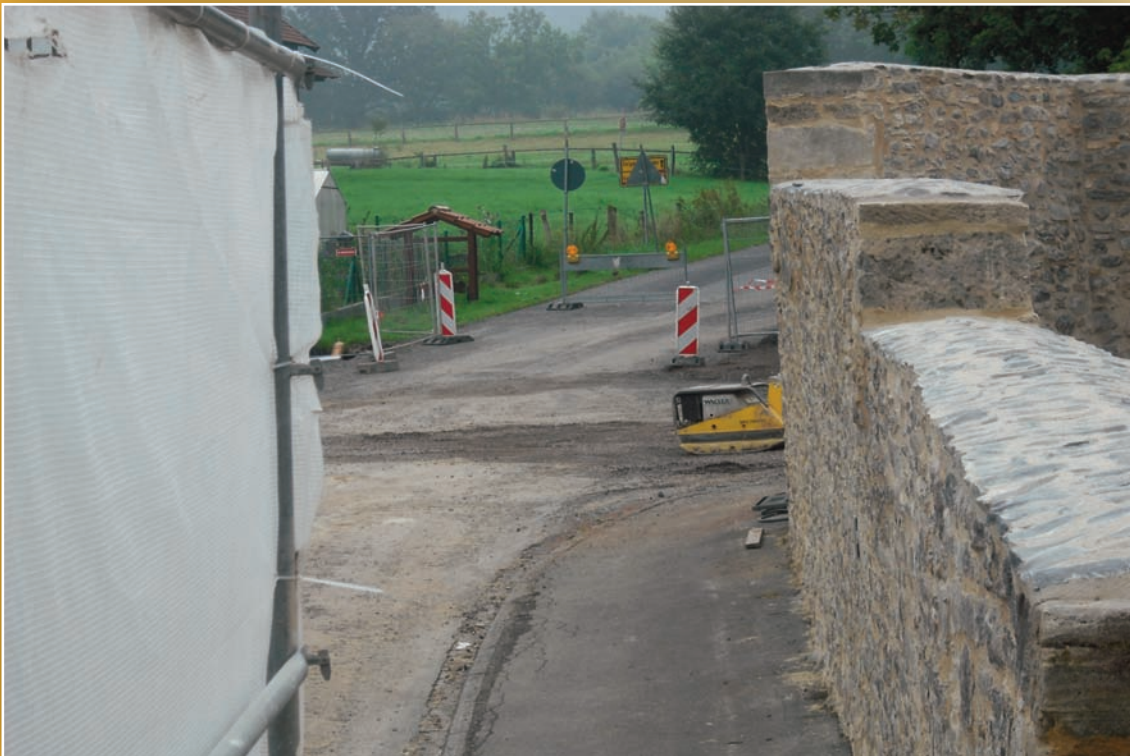
Neuverfugte Mauerkrone mit einem Trass-Werksteinmörtel Spezial TWM-S, Fabr. Tubag
