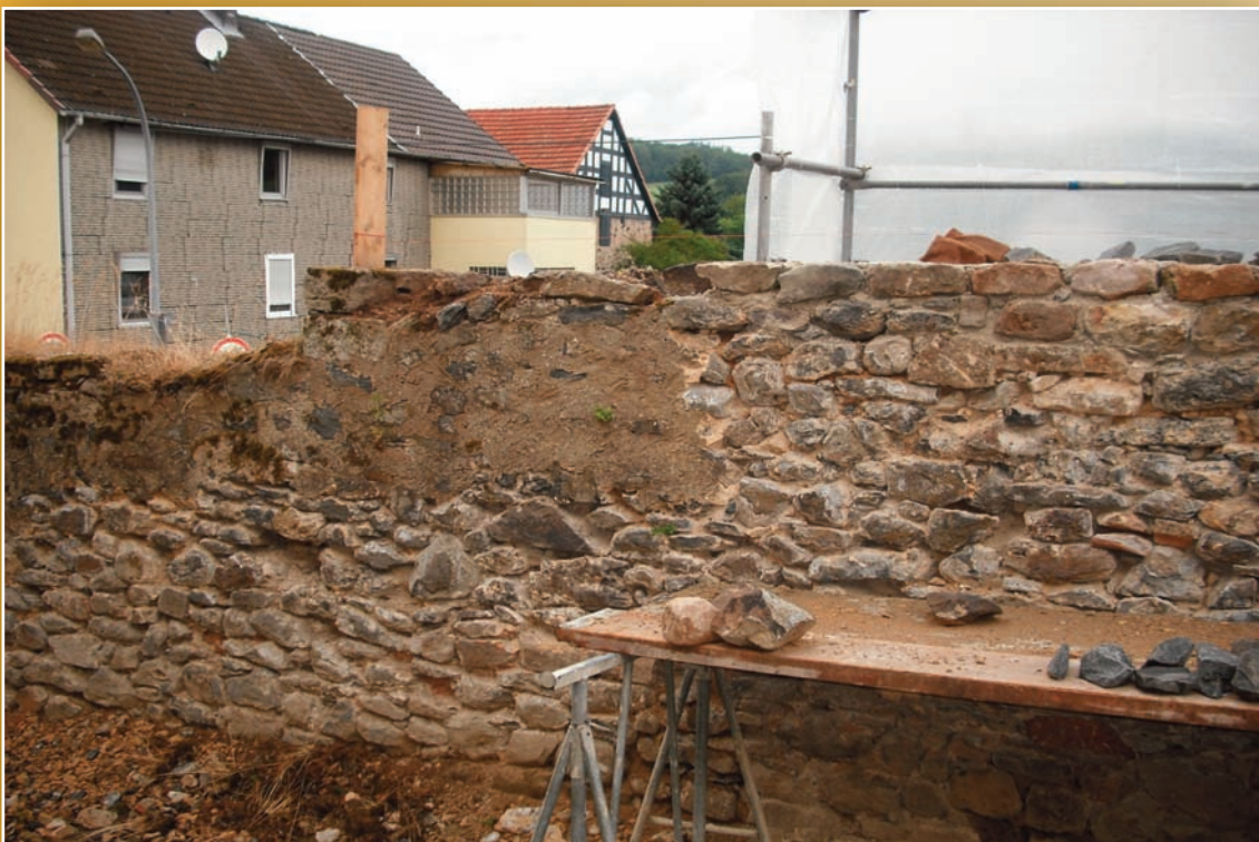
Vorbereitungsarbeiten für die Neuverfugung
