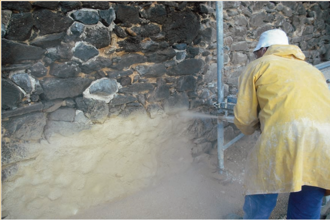
Verfugarbeiten am Eckturm mit einem NHL-Mörtel, Fabr. Tubag
