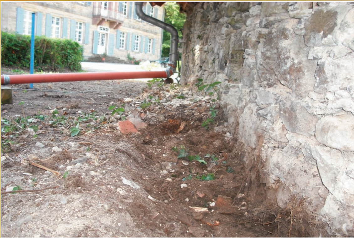
Erdarbeiten am Mauerfuß
