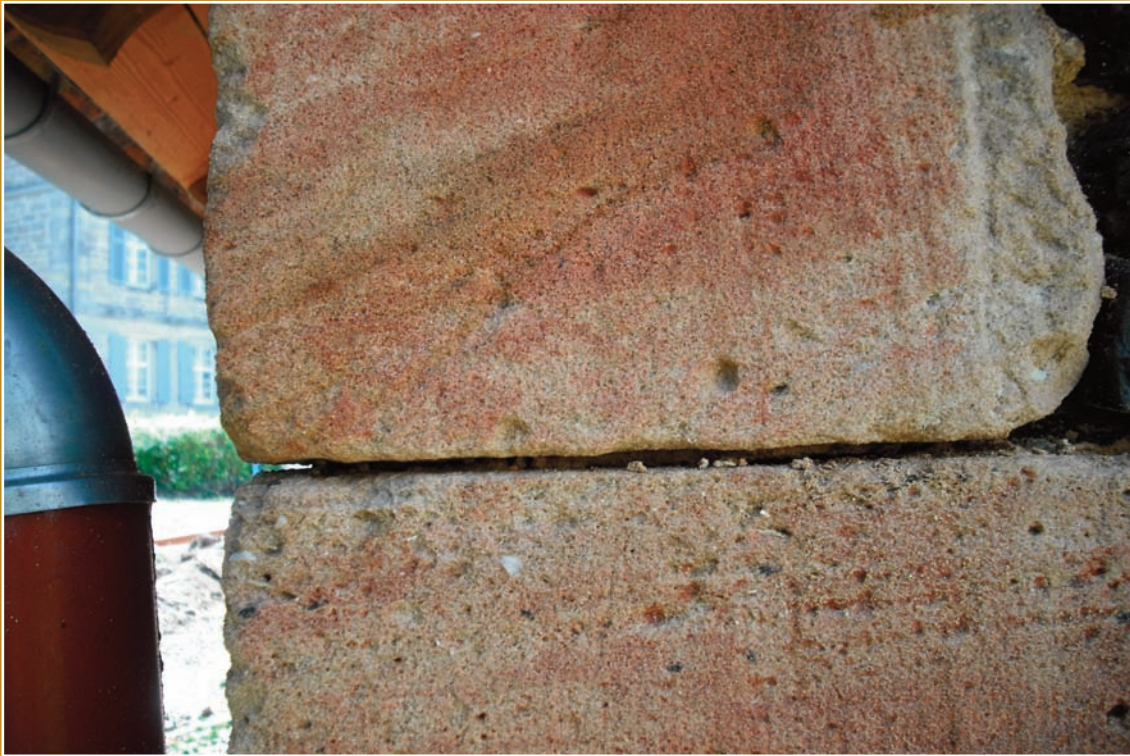
Vorbereitung der Eckquader für die Verfugarbeiten
