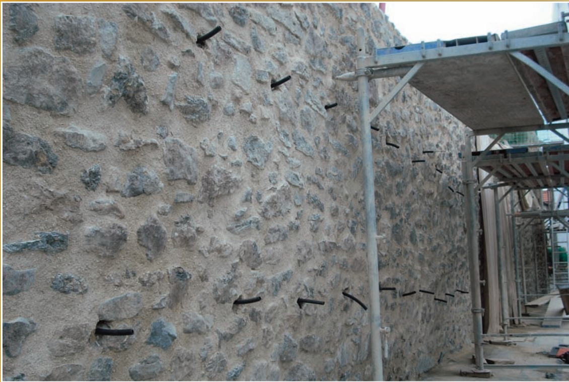
Injektionsröhrchen für Verpressung der Nadelanker
