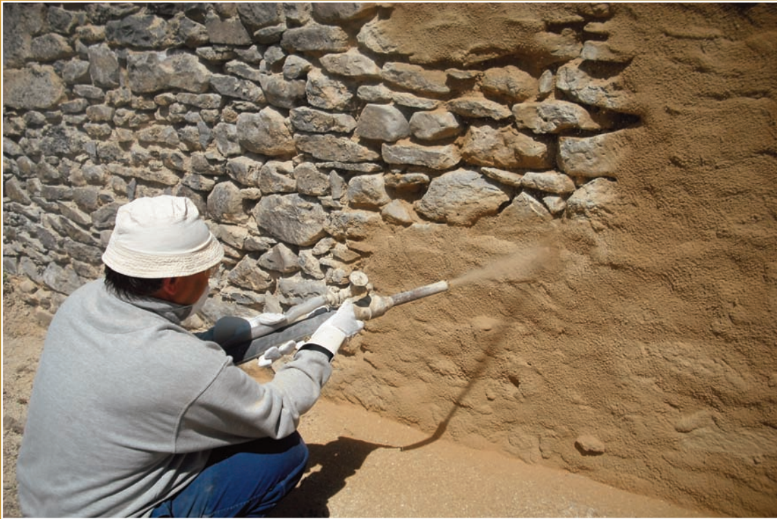
Steinsichtige maschinelle Verfugung im Hochdruckspritzverfahren mit einem NHL-Mörtel, Fabr. Tubag
