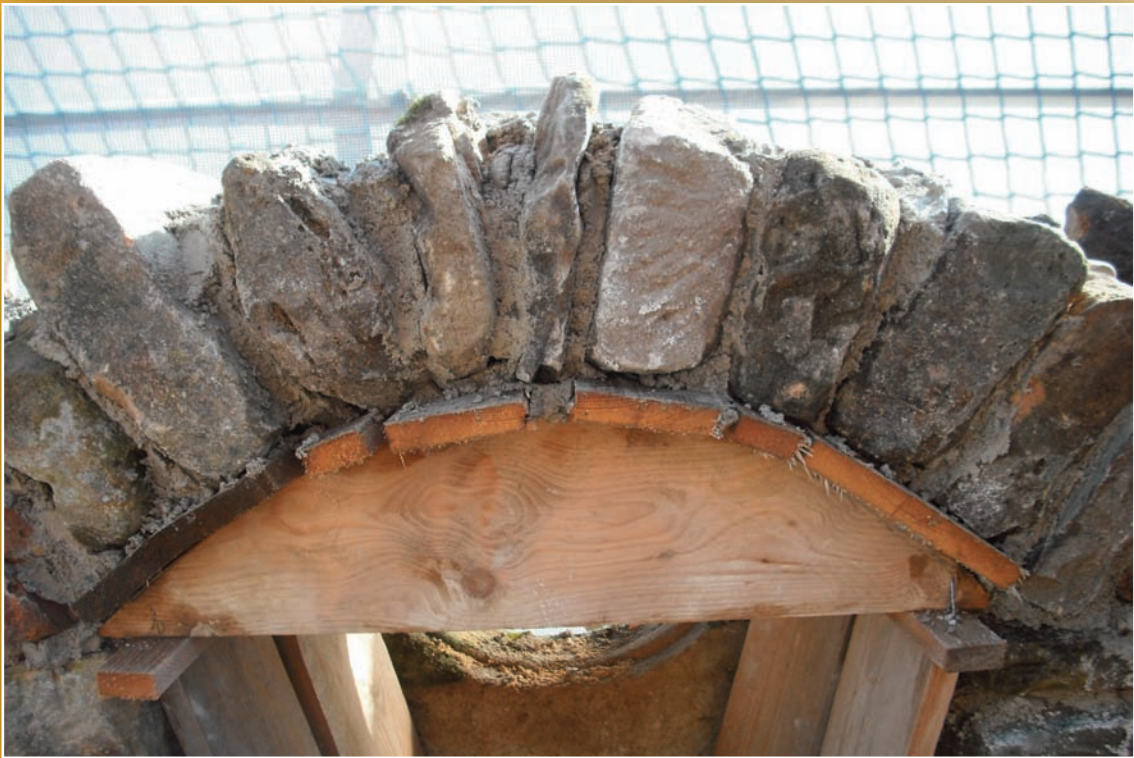
Herstellung der Fensterbögen
