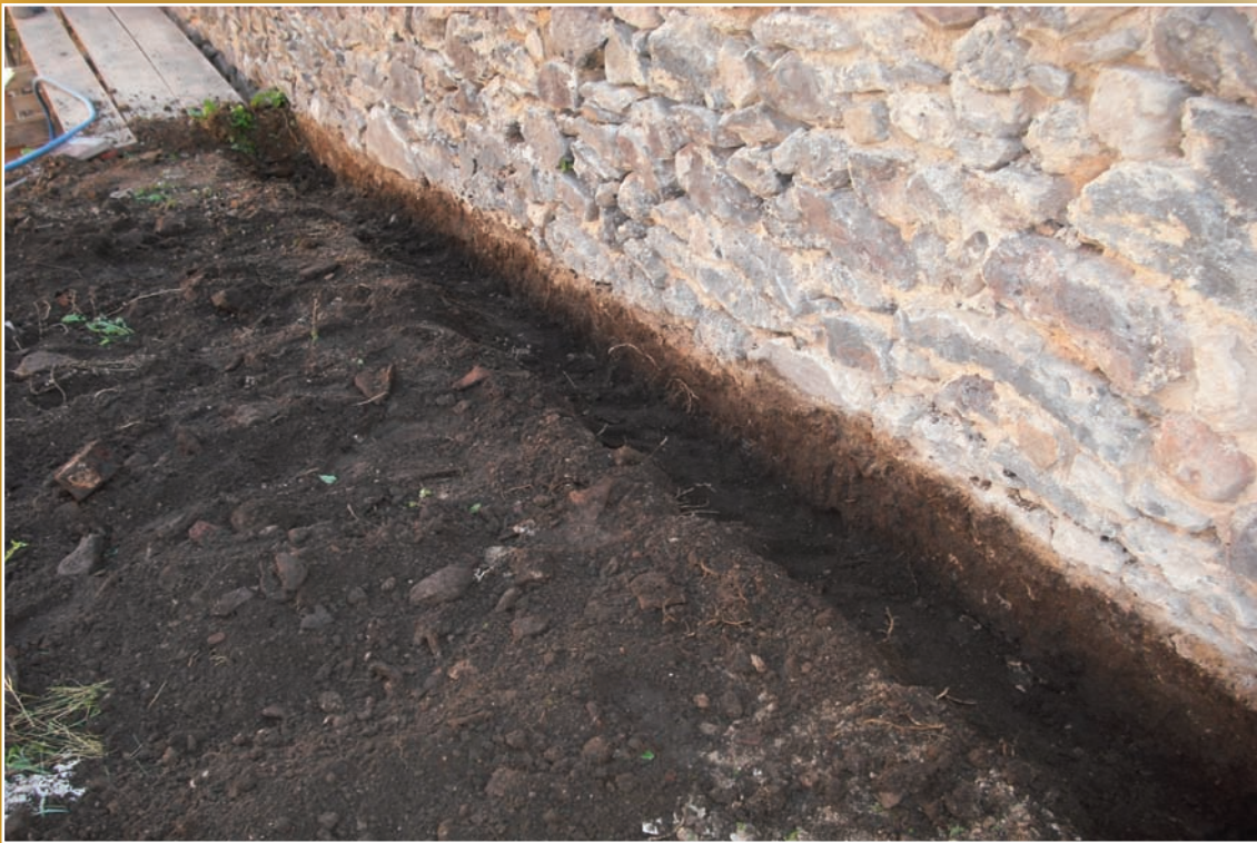
Erdaushub im Fußbereich der Wandfläche
