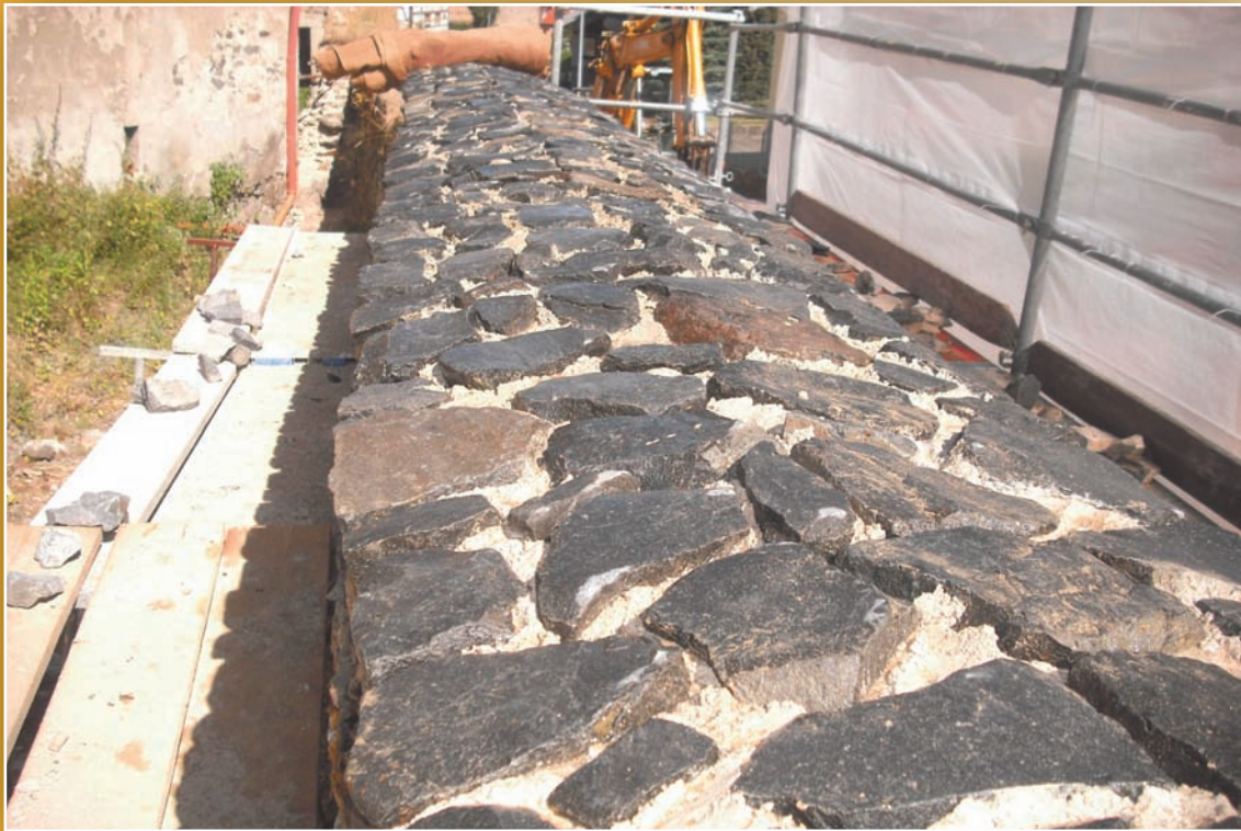
Mauerkrone vor dem Verfugen
