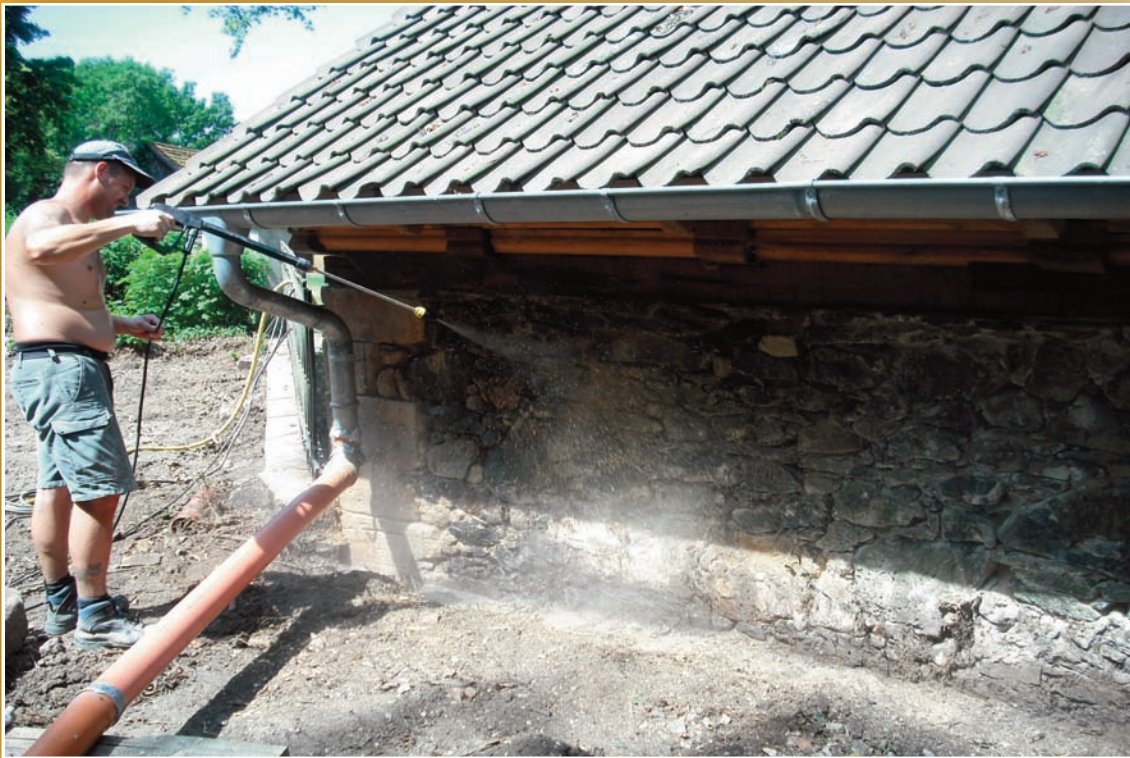
Reinigung der Wandflächen
