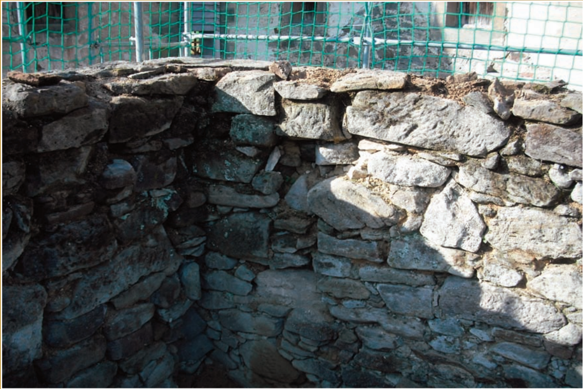
Mauerkrone am Eckturm
