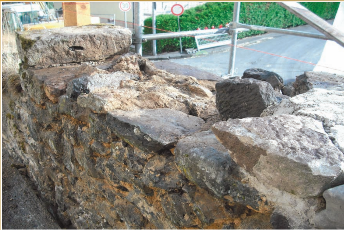
Herstellung der Mauerkrone
