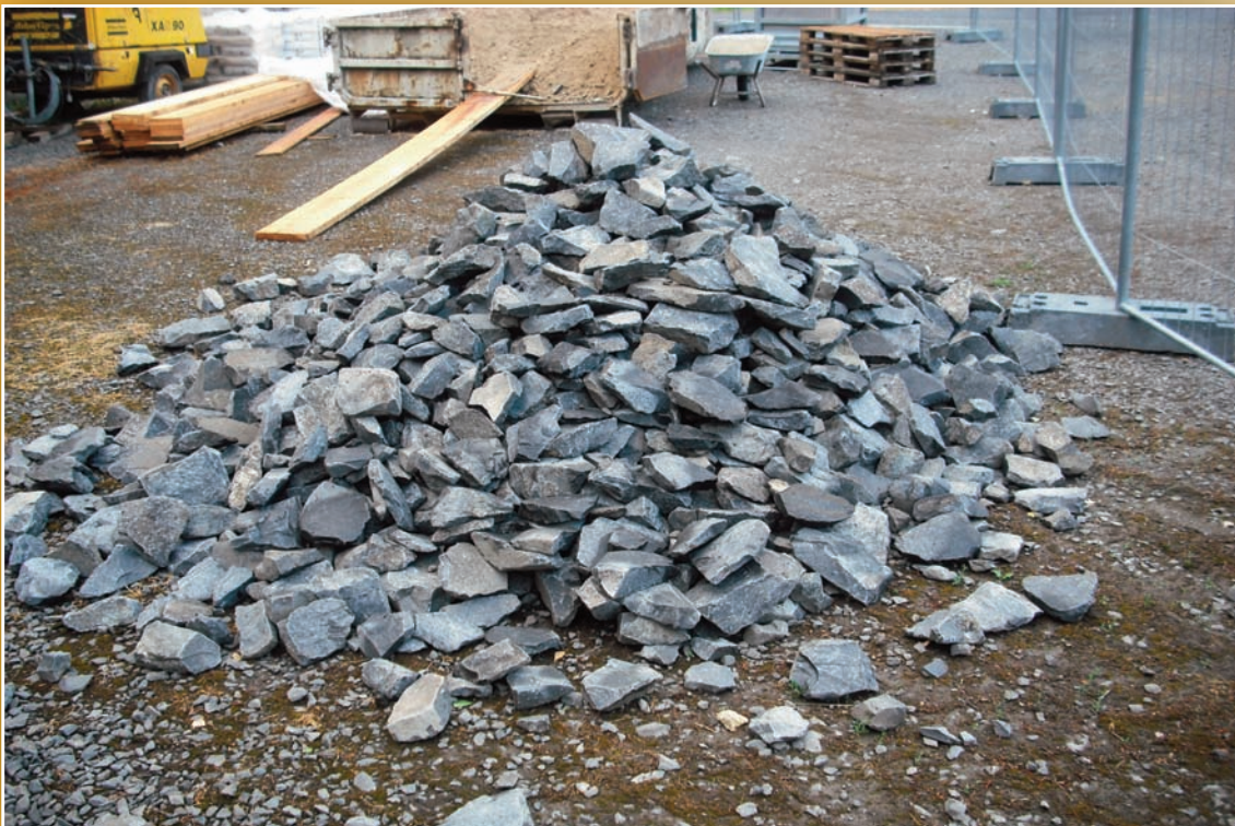
Basaltsteine für Mauerkrone BA1
