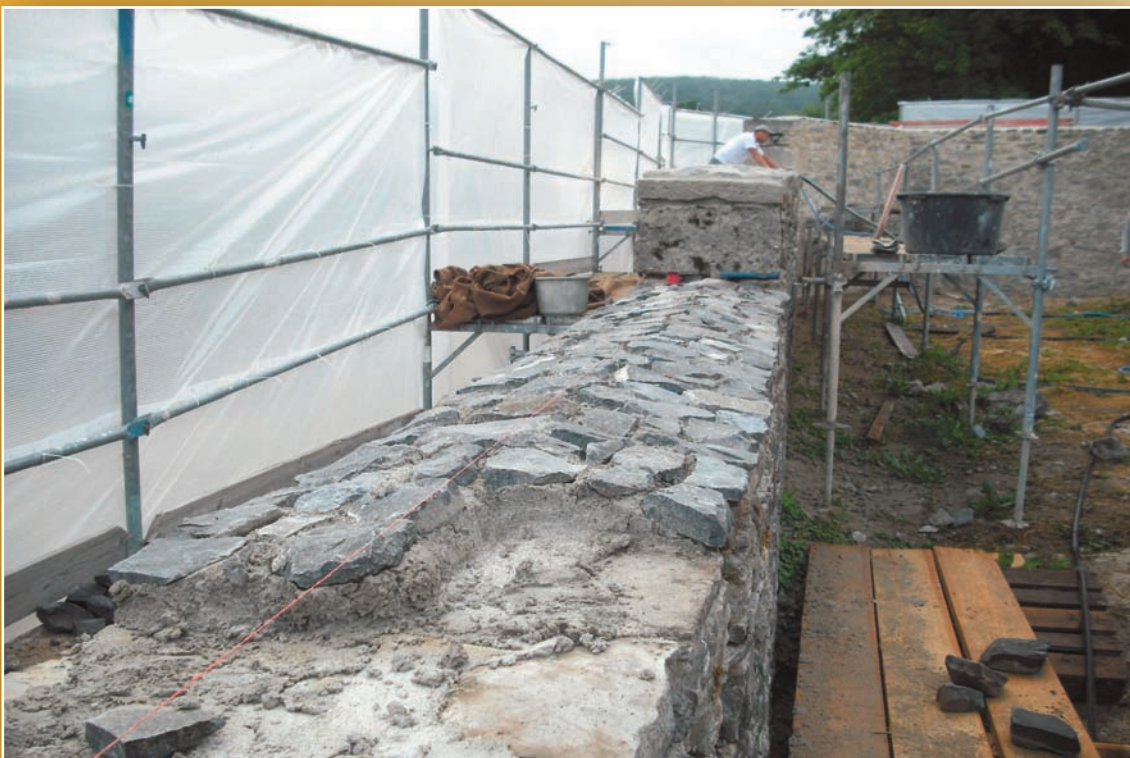
Herstellung der Mauerkrone mit einem historischen Mauermörtel MGPIIa Werkmischung, Fabr. Otterbein
