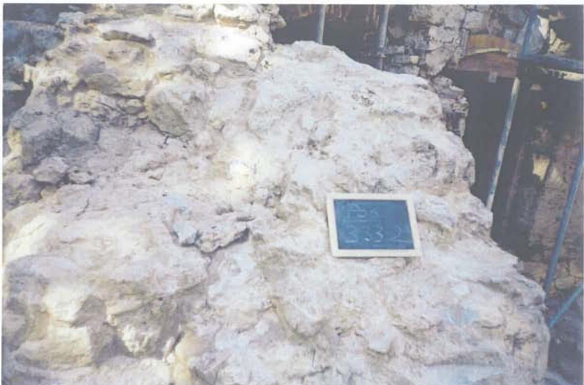
Anmerkungen: Mauerwerk des Turmstumpfes von oben nach Reinigung und Entwurzelung.
