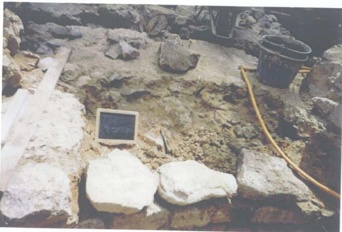
Anmerkungen: Aufmauern von Becken zur Herstellung der Wasserführung.
