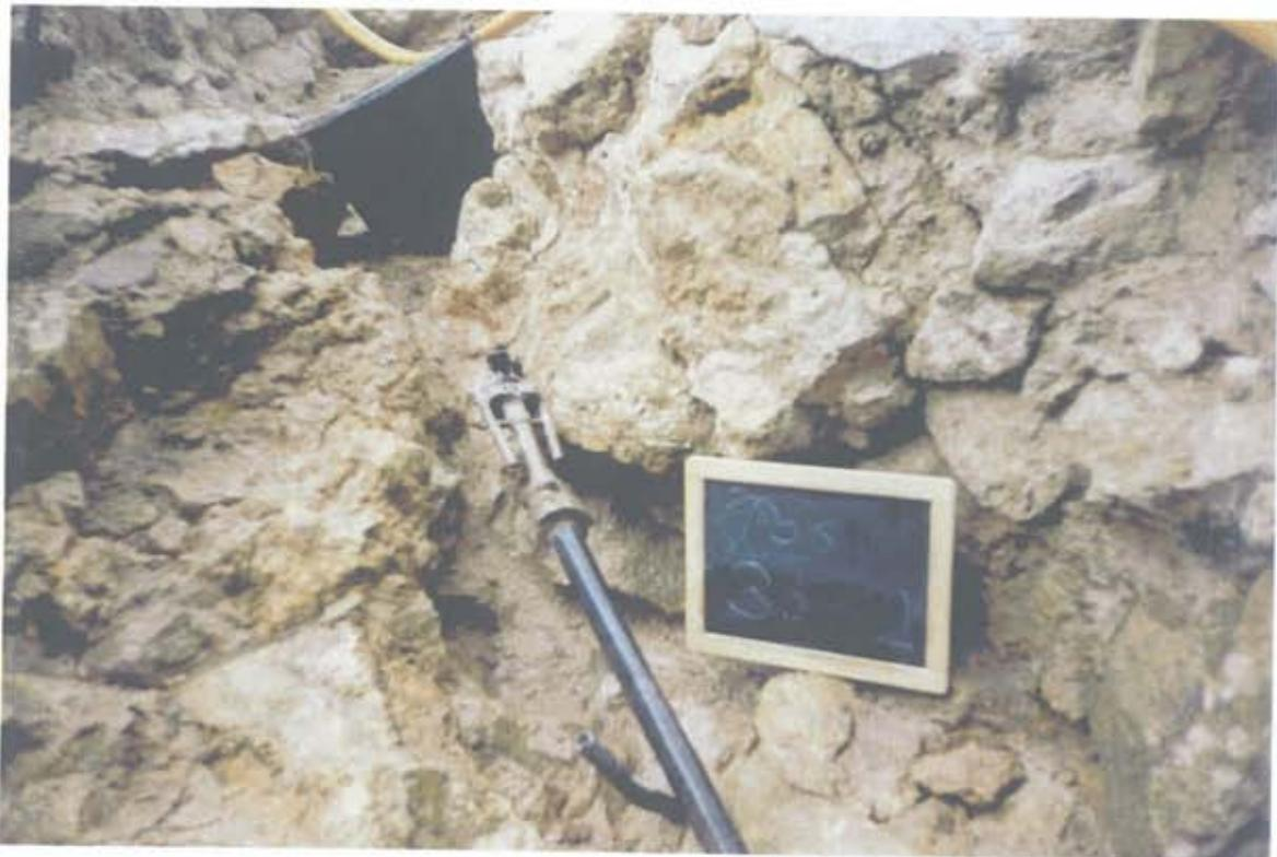
Anmerkungen: Verpress/ Verfüllzange auf Verfüllstutzen
