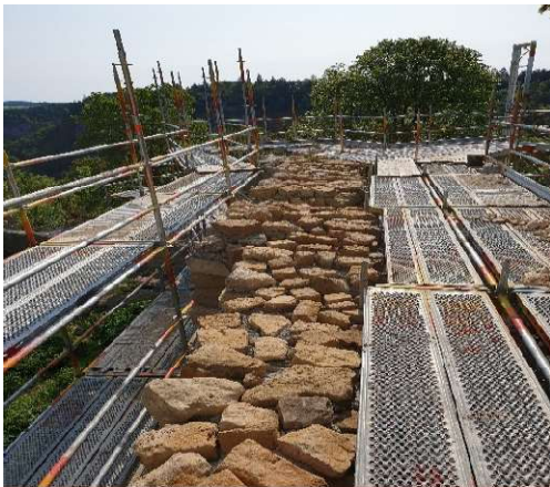
Mauerkrone vor der Verfugung
