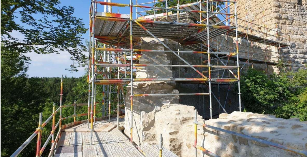
Mauer- und Fugarbeiten
