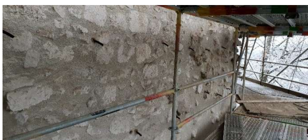
Verfüll-, Verpressarbeiten
