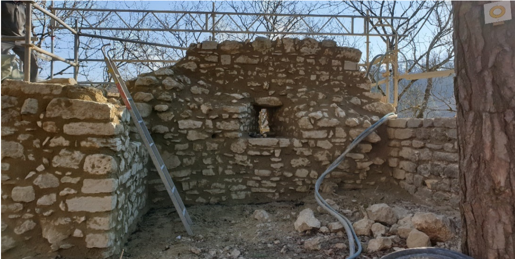
Bei der Verfugung
