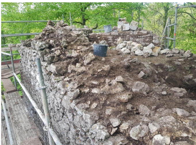
Freigelegte Mauerkrone
