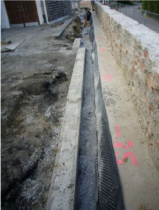
Drainage und Fundation
