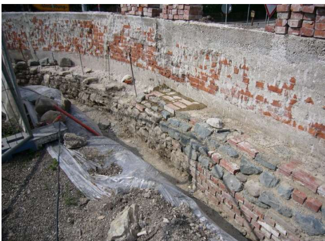
Drainagearbeiten, freigelegtes Fundament
