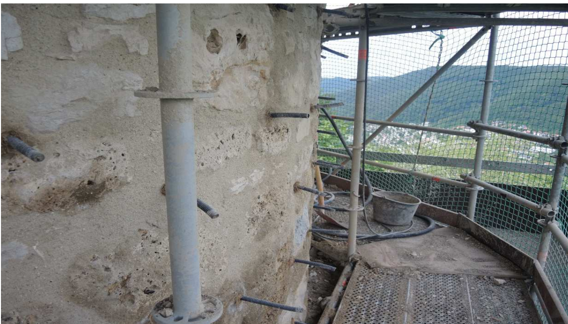
Verpressarbeiten östlicher Turm
