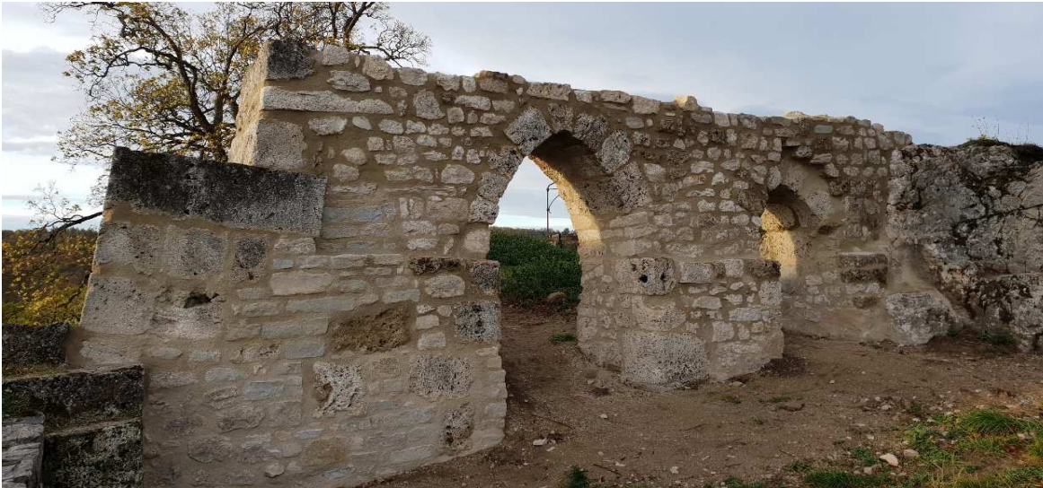
Mauer- und Fugarbeiten Großer Saal
