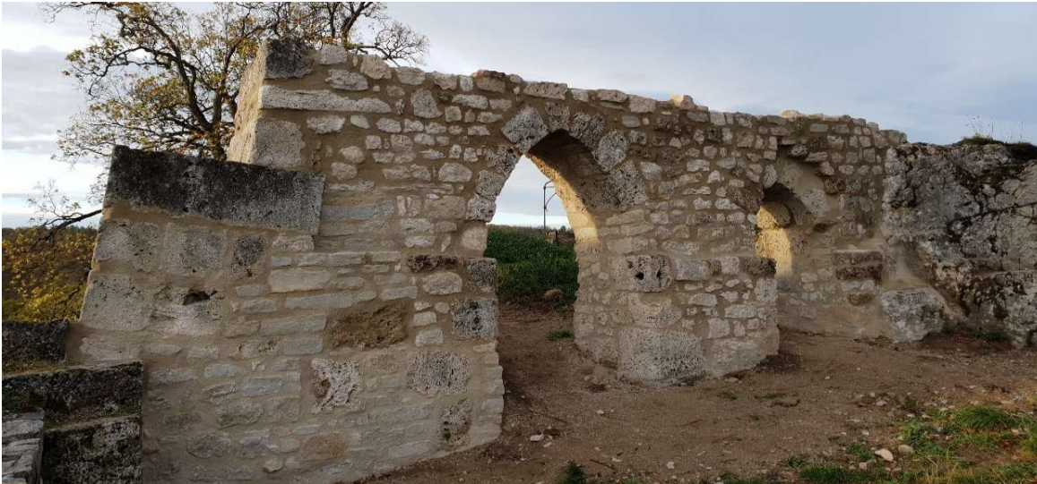
Mauer- und Fugarbeiten Großer Saal
