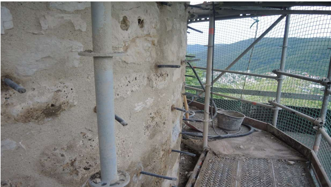
Verpressarbeiten östlicher Turm
